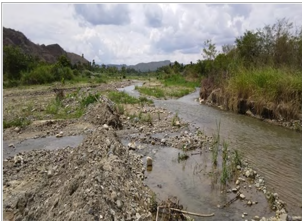
Fotografía N° 02: Colmatado de la Bocatoma Canal Las Plazas.
