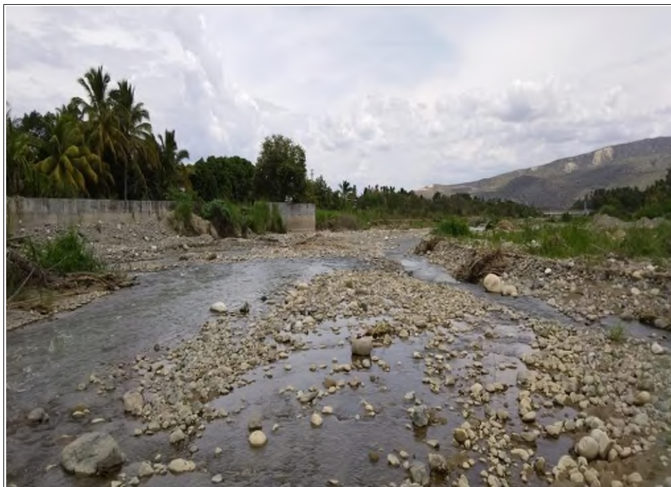
Fotografía N° 04: Destrucción y colmatado de la Bocatoma Canal Las Juntas.
