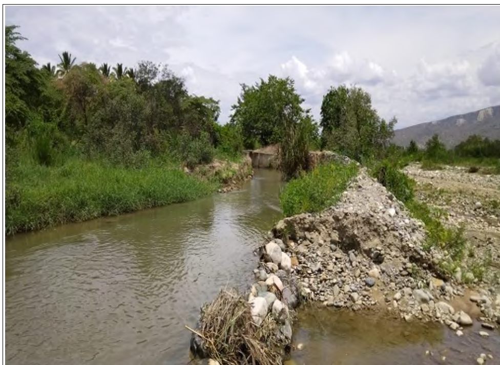
Fotografía N° 02: Colmatado de la Bocatoma Canal Las Plazas.
